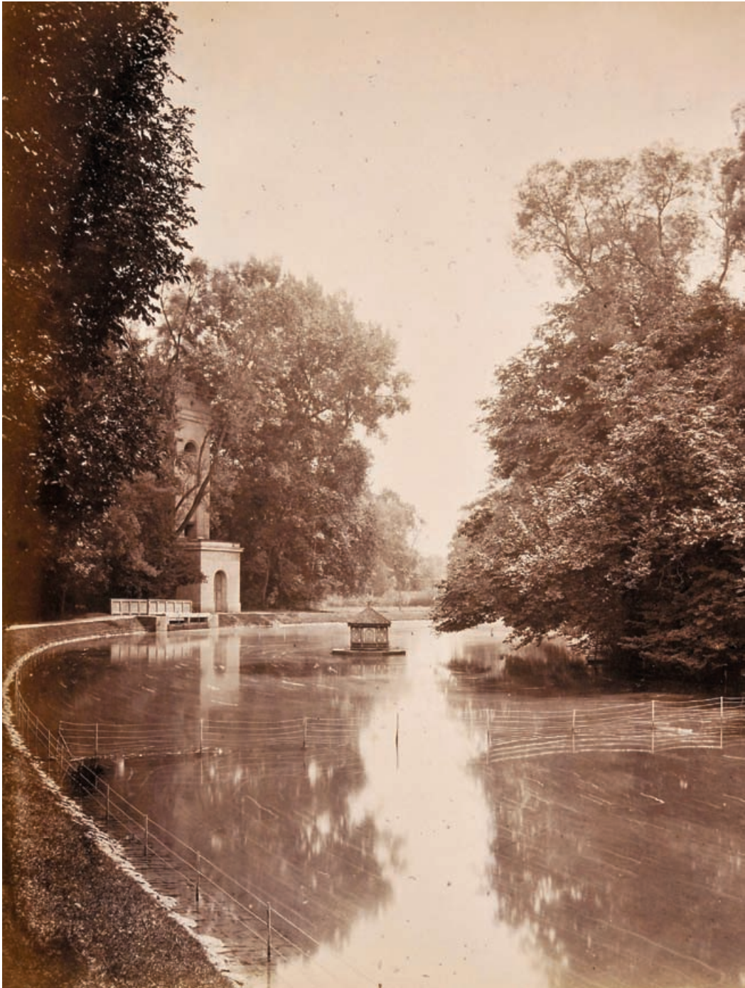
Wasserturm am Schwanenweiher (Situation etwa 1860).
