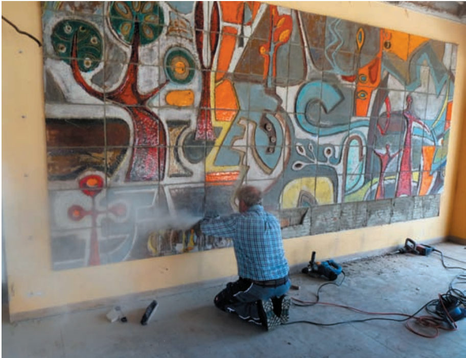
Abbau des Wandreliefs in der Kinderklinik.
