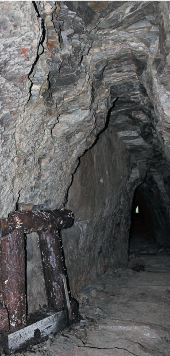
Bergwerk „Karl im Mailänder“, Blickrichtung nach außen.
