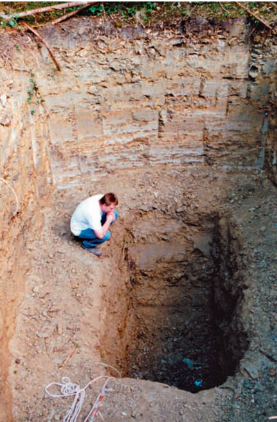
Bergwerk „Karl im Mailänder“, Fundamentgrube für die Schachtsicherung. In der Mitte der noch größtenteils verfüllte Schacht.
