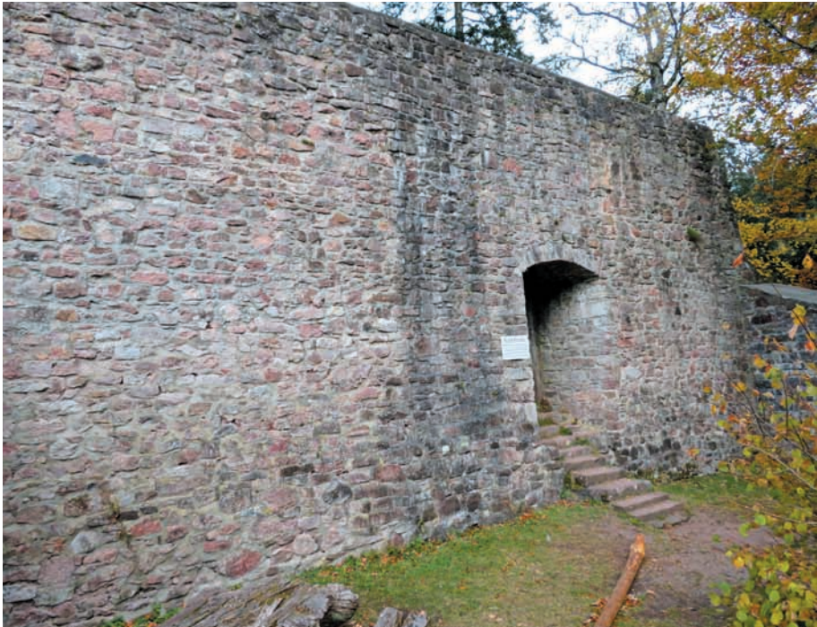
Wand der Ruine Kirneck, die 2010 renoviert wurde. Fotos: Hannah Miriam Jaag.
