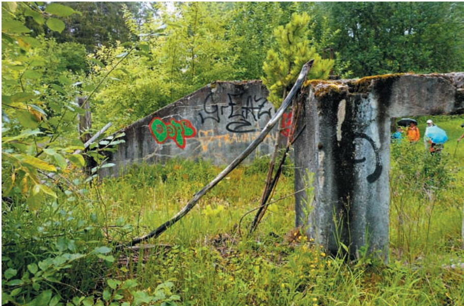
Die Verlade- und Sortierrampe, heutiger Zustand. Foto: Josef Vogt.
