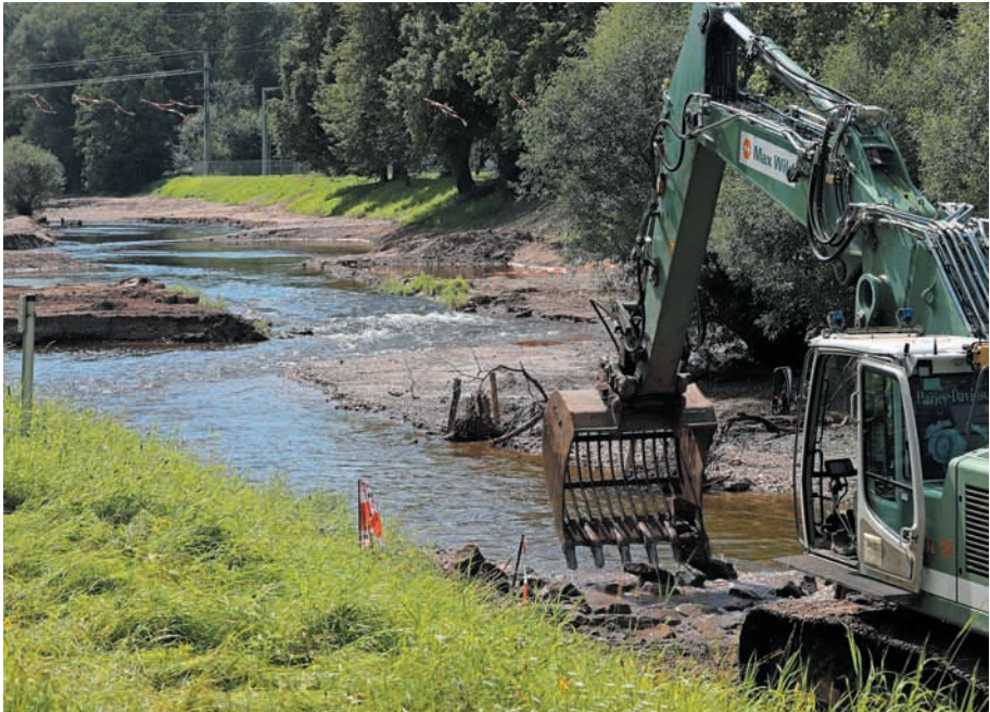
Gestaltungsmaßnahmen: Inseln, Kiesbänke, Stromschwelen entstehen (August 2021).
