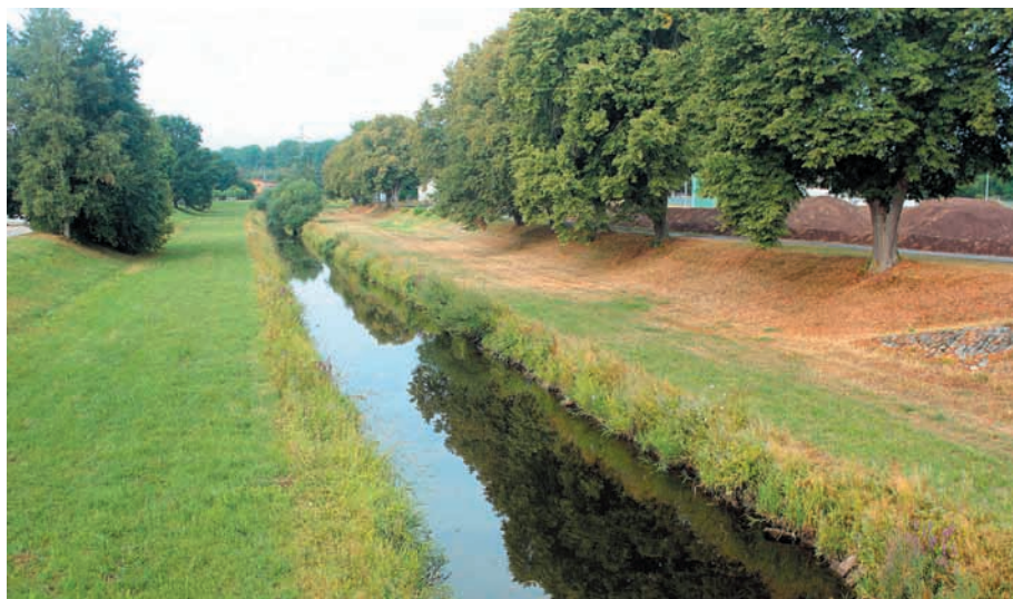
Der kanalisierte Unterlauf der Breg vor Beginn der Maßnahme (August 2020). Alle Fotos: Helmut Gehring.
