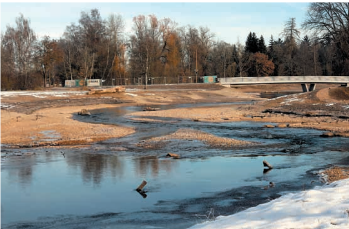
Die Breg in ihrem neuen Bett. Im Hintergrund die neu gebaute Brücke, die aufgrund der Umleitung der Breg erforderlich wurde (Januar 2022).
