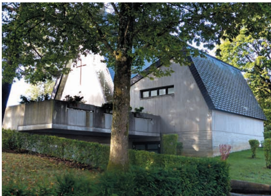
Dauchingen, Anbau der Aussegnungshalle.
