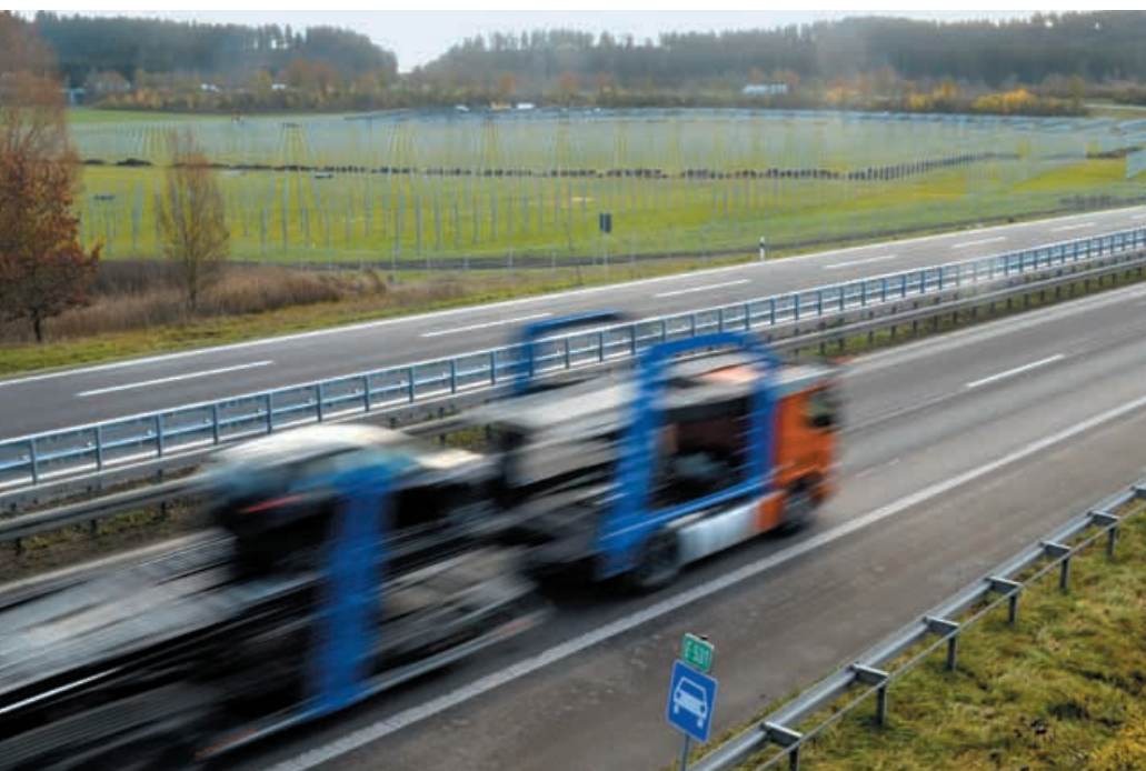
An der B33/27 entsteht die Agri-Photovoltaikanlage Donaueschingen-Aasen.
